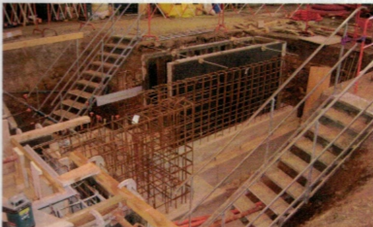
Le génie civil de la fosse de réception de la dérouleuse a été confié à Jean-Luc Martinazzo, une entreprise locale.
